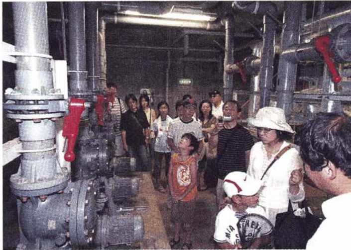
△ 普段入れないポンプ室を見学する来館者
